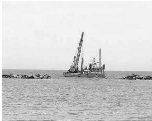
Il pontone per i lavori
