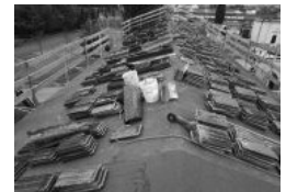
I lavori sul tetto
