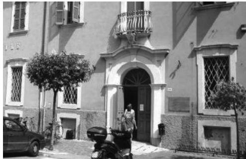
L'ingresso del Santa Colomba
