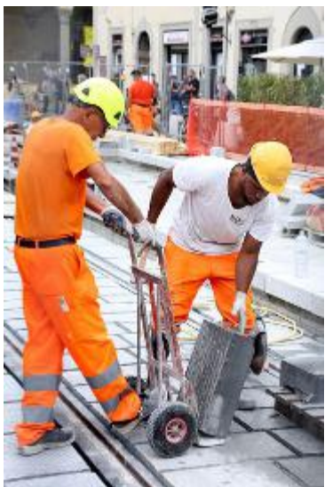
Operai in un cantiere
