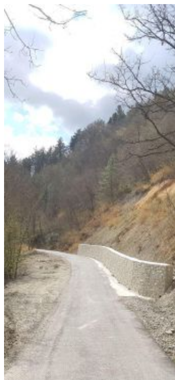
Il tratto di strada interessato dai lavori di messa in sicurezza
