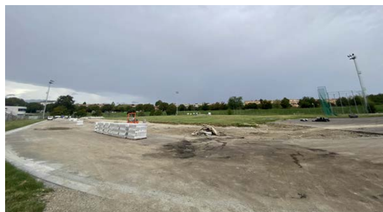
Qui sopra i lavori, in alto la vista a computer di come sarà la pista d'atletica
