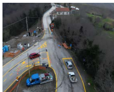
I lavori sulla Strada provinciale 11
