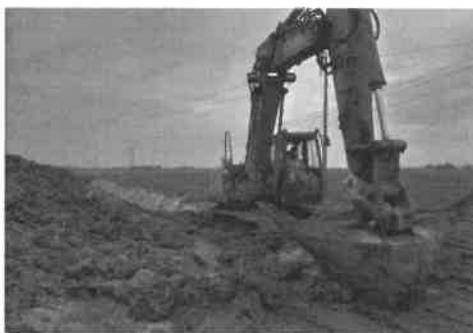
I lavori in località Casemurrate
