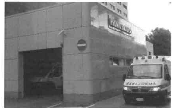
Via ai lavori che prevedono un ampliamento del pronto soccorso di Vecchiazano
