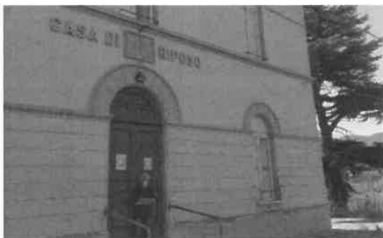
L'affidamento del cantieri per i lavori alla casa di riposo risale all'aprile 2020
